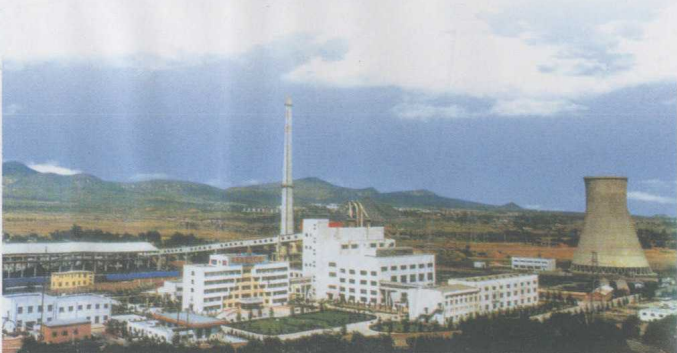
河南省平顶山坑口电厂工程一角
