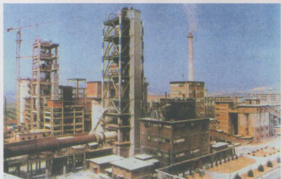
河南省七里岗水泥厂工程一角
