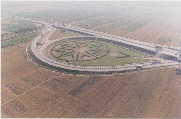
国道 107 与安新路交汇处
