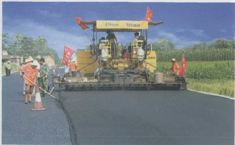
ABG423 摊铺机在 312 线西峡境施工
