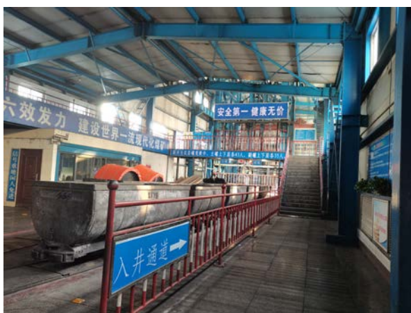
首山一矿行人副井
