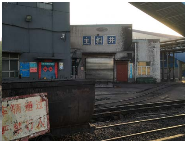
首山一矿主斜井
