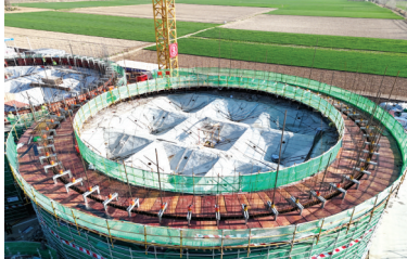
中交一公局集团郑州粮储项目正在进行滑模模板安装作业。倪祥 摄
