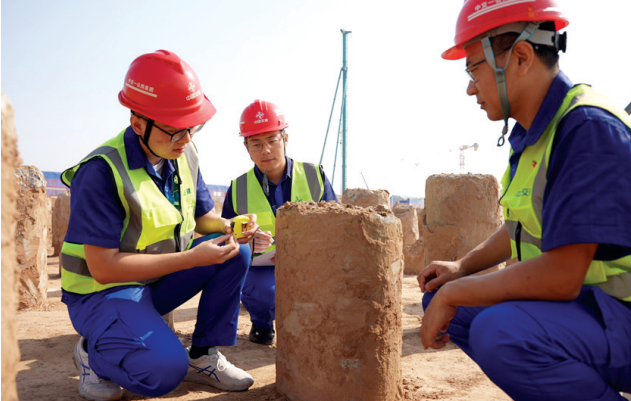
中交一公局集团郑州粮储项目负责人姚明带团队验收桩基垂直度。郭苗华 摄
