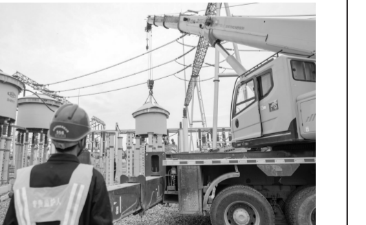
检修人员对500千伏螺祖变电站开展电抗器更换作业。
