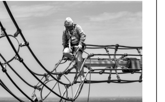
带电作业人员对1000千伏豫武Ⅱ线开展线路缺陷消除。
