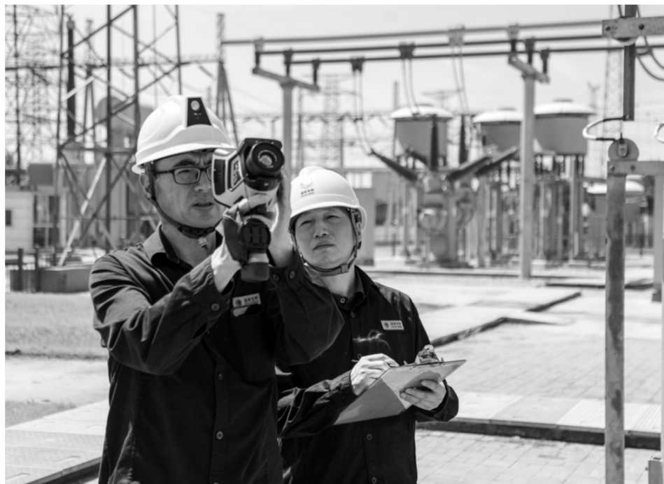
运维人员对500千伏郑州变电站开展特巡特护。
