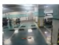
绿都城47.48号楼地下车位
