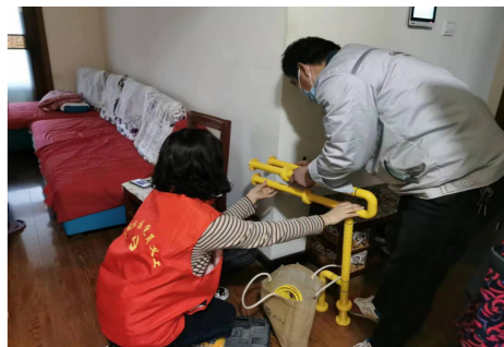
图6 适老化安装安全扶手
