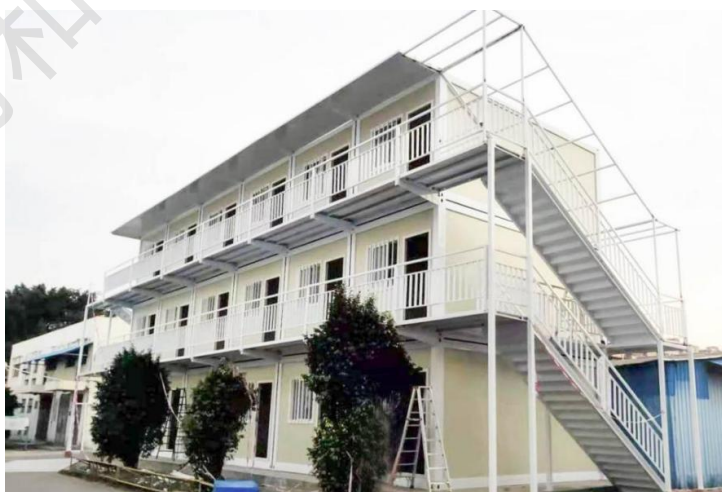
图 1.0.2 可拆装式箱型轻钢结构组合房屋
