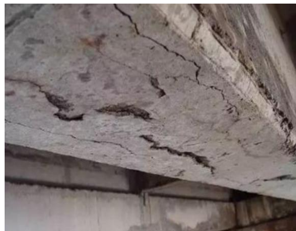
图 9.1.2-8 梁底部开裂
