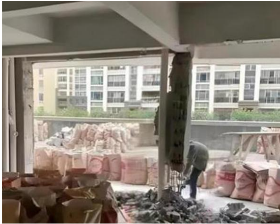
图 4.2.1-1 框架柱拆除
