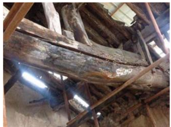
图 9.1.2-12 屋架劈裂
