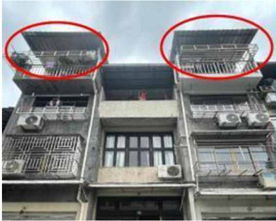
图 4.2.6-1 加建悬挑阳台
