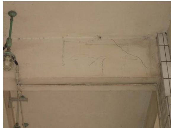
图 9.1.2-10 梁受剪裂缝
