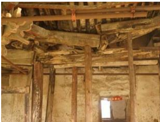
图 9.1.2-11 屋架断裂
