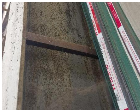
图 9.1.2-14 钢柱锈蚀
