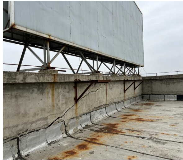
图 5.1.24-2 女儿墙上安装大型广告牌
