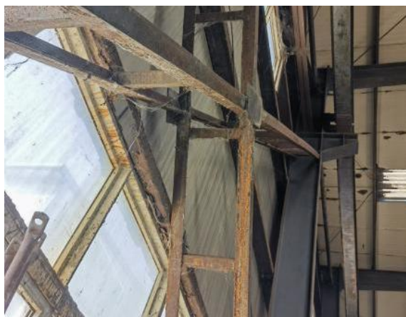
图 9.1.2-13 斜撑锈蚀
