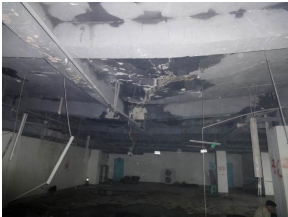
图 9.1.2-9 梁受弯裂缝
