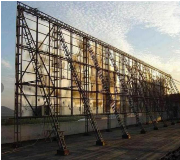
图 5.1.24-1 屋面大型广告牌
